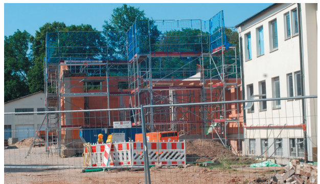
Noch Baustelle: 2020 wird ins neue Uehlfelder Rathaus auch eine LEADERgeförderte Bücherei einziehen
