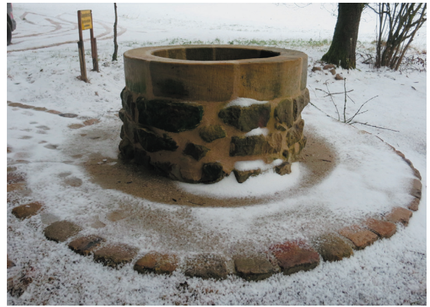
2019 ebenfalls abgeschlossen: der Brunnen am Sichertshof, Gemeinde Lonnerstadt
